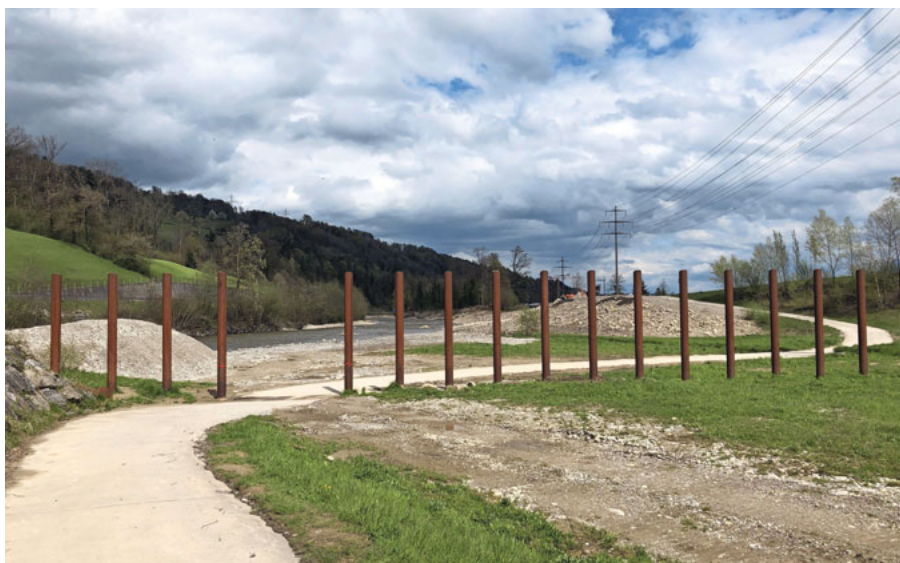
Das Holzurückhaltebecken Rechen 2 bei der Kleinen Emme. Bild: zvg
