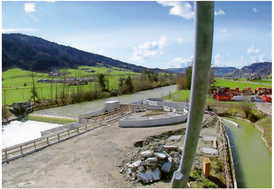
Die Fischwanderhilfen stellen sicher, dass Fische wieder in der Kleinen Emme auf- und abschwimmen können. Bild: zvg
