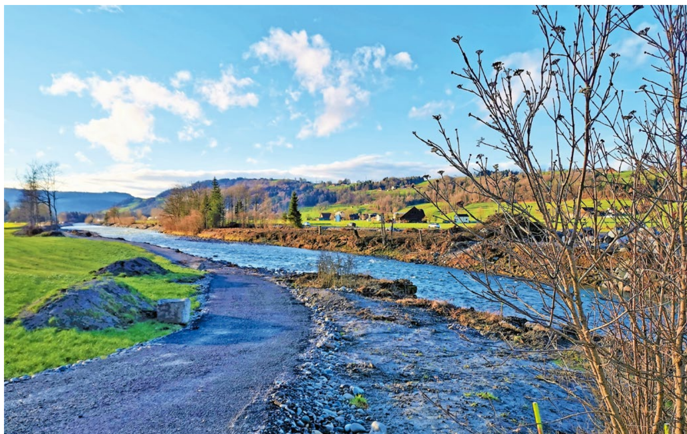
13. Januar 2023: Kleine Emme, Renaturierungsarbeiten bei der Blattner-Brücke (Foto: Urs Gutfleisch).
